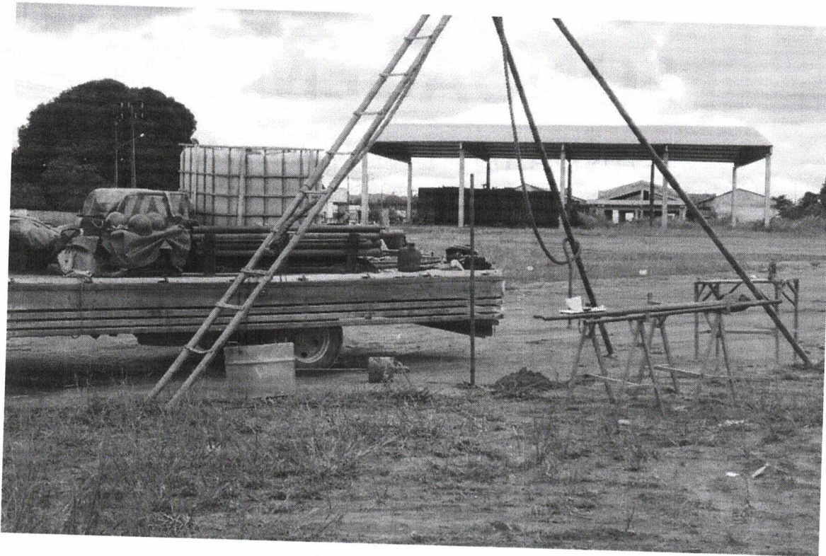
EXECUÇÃO DE SONDAgens NO LOCAL
